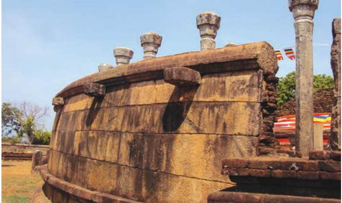
තිරියාය වටදාගෙයි ප්‍රාකාර හා වහලයේ කරැපාව සඳහා ප්‍රාකාරයෙන් ඉදිරියට ප්‍රක්ෂේපණය වන නළාඳ දඬු
